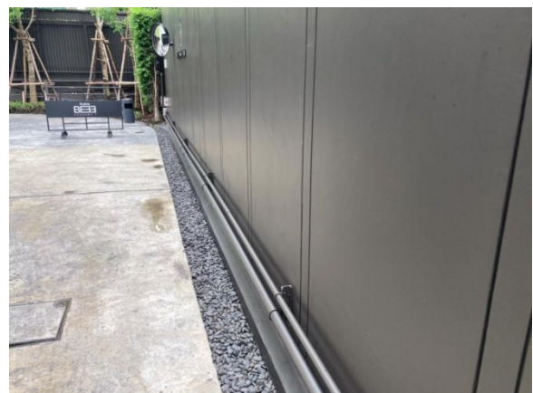
รูปที่ 2-33 รางระบายน้ำของโครงการ
