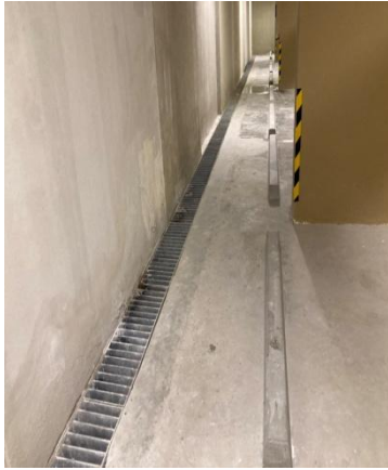
รูปที่ 2-34 จัดให้ชั้นใต้ดินที่ 1-2 มีท่อระบายน้ำเพื่อรวบรวมน้ำฝนไปยังบ่อสูบน้ำ
