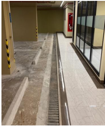
รูปที่ 2-35 จัดให้ชั้นใต้ดินที่ 3-5 มีท่อระบายน้ำเพื่อรวบรวมน้ำฝนไปยังบ่อสูบน้ำ
